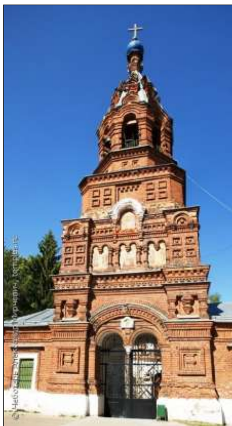
Деревня Чашниково. Колокольня церкви Святой Троицы (отдельно стоящая), вид с юга (фото 2011 г.).
