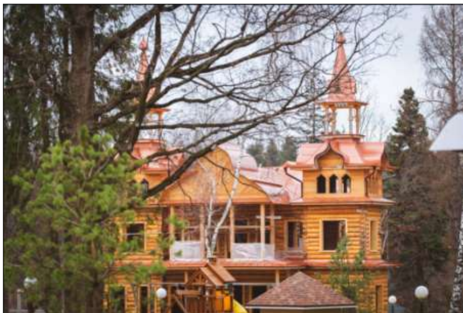
Фото. Работы по воссозданию дачи Проскуряковых, 2013 год.
