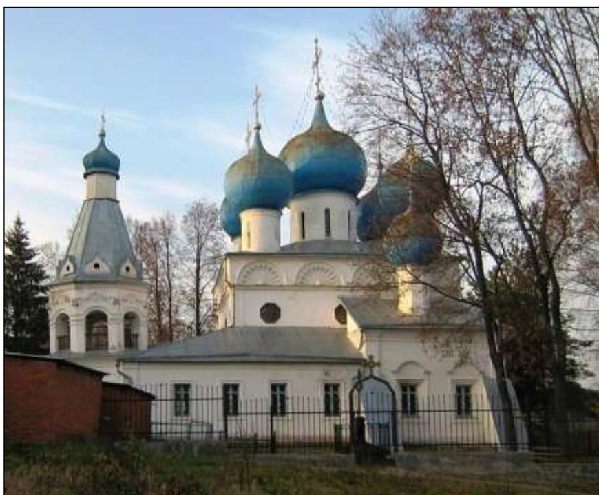
Деревня Чашниково. Церковь Троицы, XVI в., вид с юга (фото 2007 г.).
