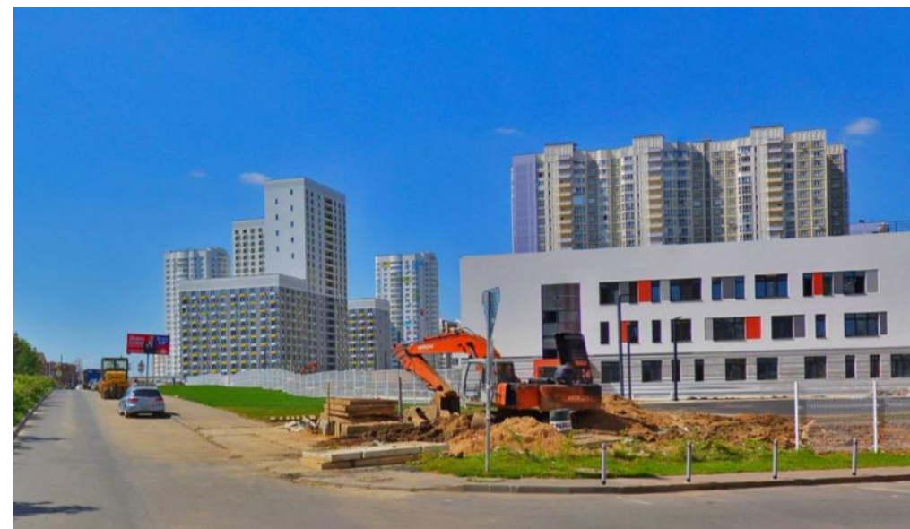
РК 173А Московская обл., г. Химки, ул. Марии Рубцовой, 200м до поворота на ул. Молодежная
