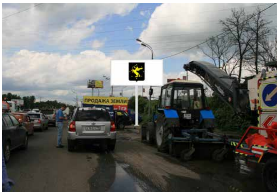
31 щит о/с, 3х6, А, Ленинградское шоссе 23,21, левая сторона
