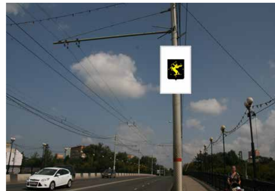
355 панель-кронштейн, 1,2х1,8, А, путепровод над ж/д, м\у 4 оп., от ул. Маяковского по направлению к проспекту Мира, правая сторона
