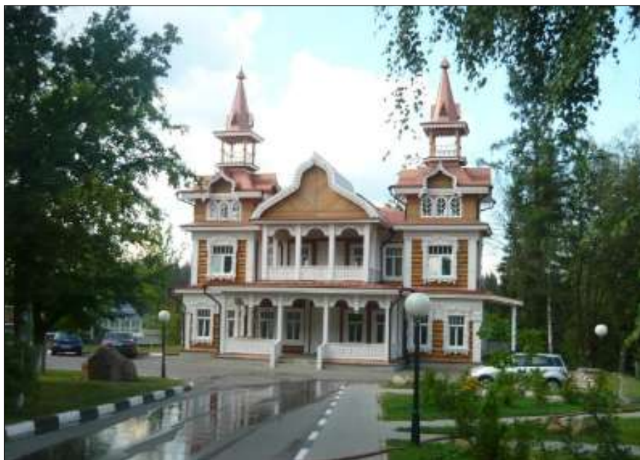
Фото. Дача Проскуряковых (воссозданный объект культурного наследия)
