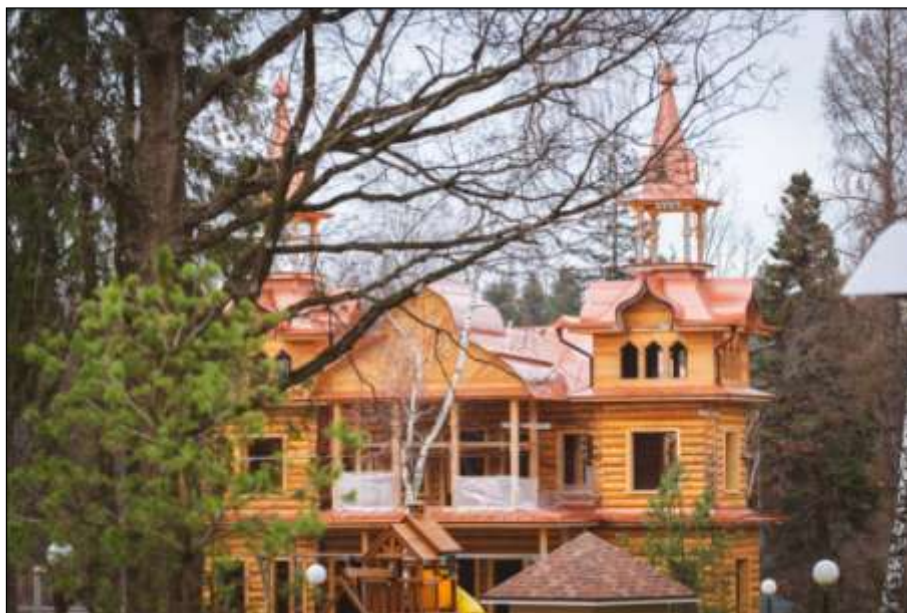
Фото. Работы по воссозданию дачи Проскуряковых, 2013 год.
