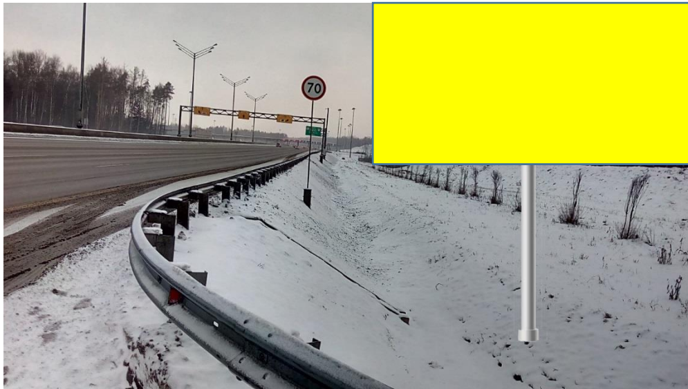
РК 858 Московская обл., г. Химки, а/д М-11 «Москва-Санкт-Петербург», 21 км, справа
