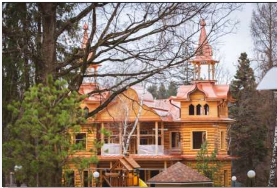
Фото. Работы по воссозданию дачи Проскуряковых, 2013 год.
