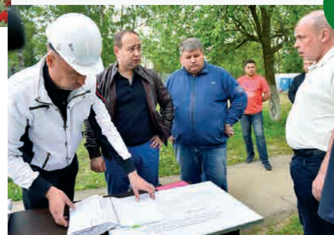
Проверка строительного процесса в рамках стройсубботы
