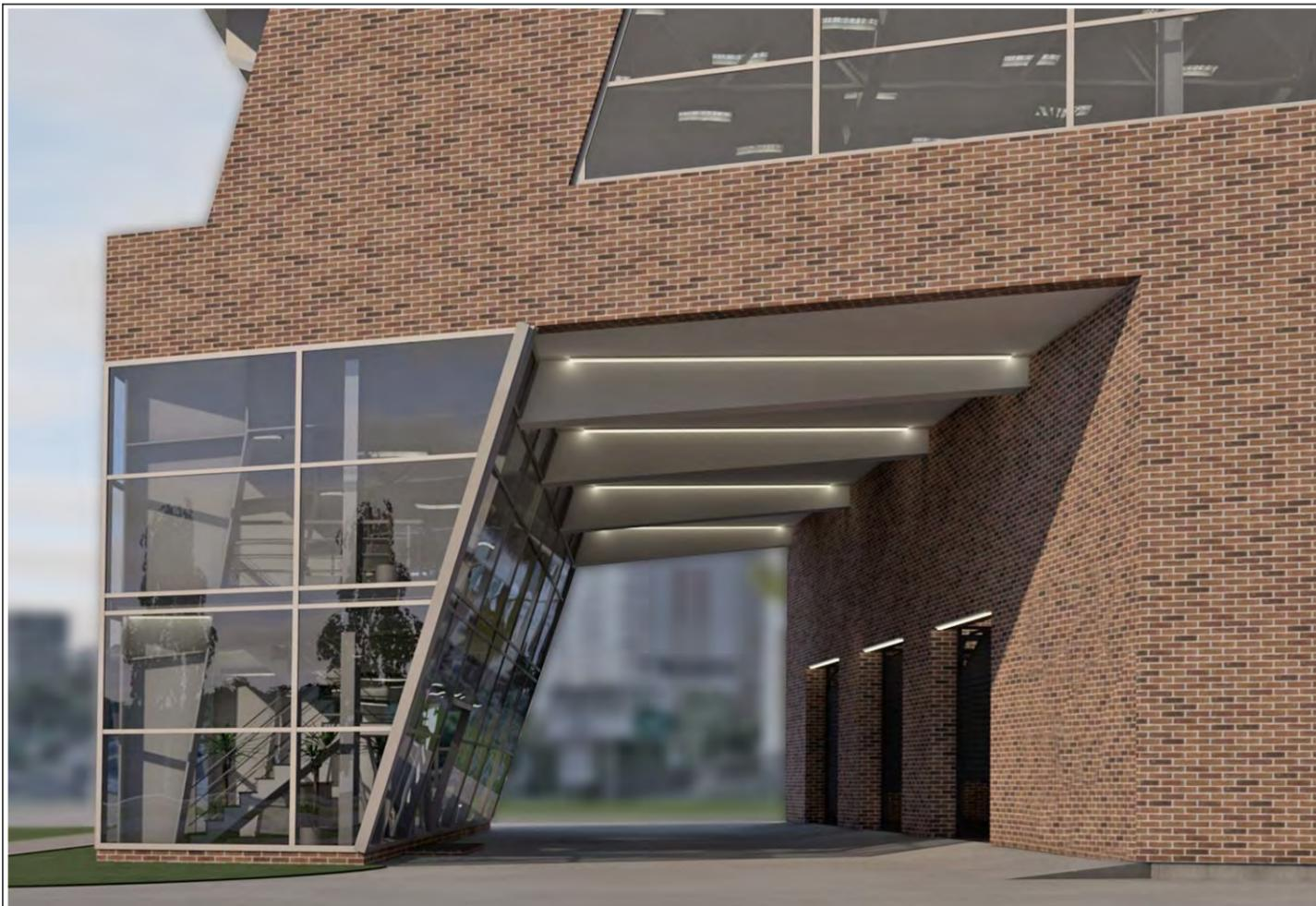
Клинкерная плитка - RAL 1019, 3009 (смешанное тонирование) - облицовка наружных стен и цоколя
