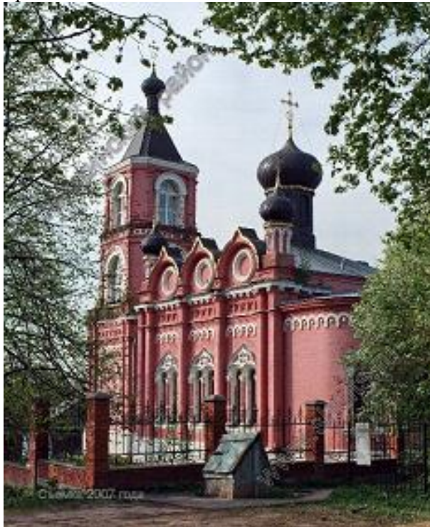
Рисунок 2.2.6. Фотография церкви в настоящее время.
